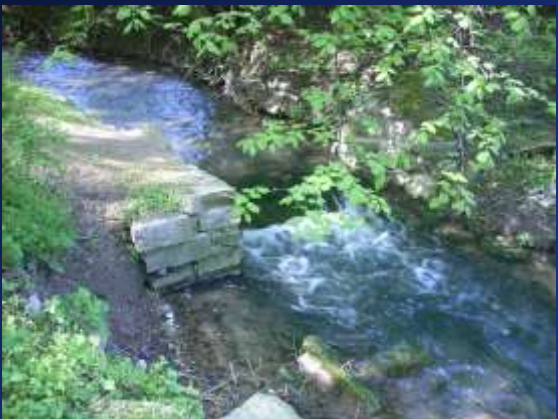
Mühlenbach, Stat. km 0+200
