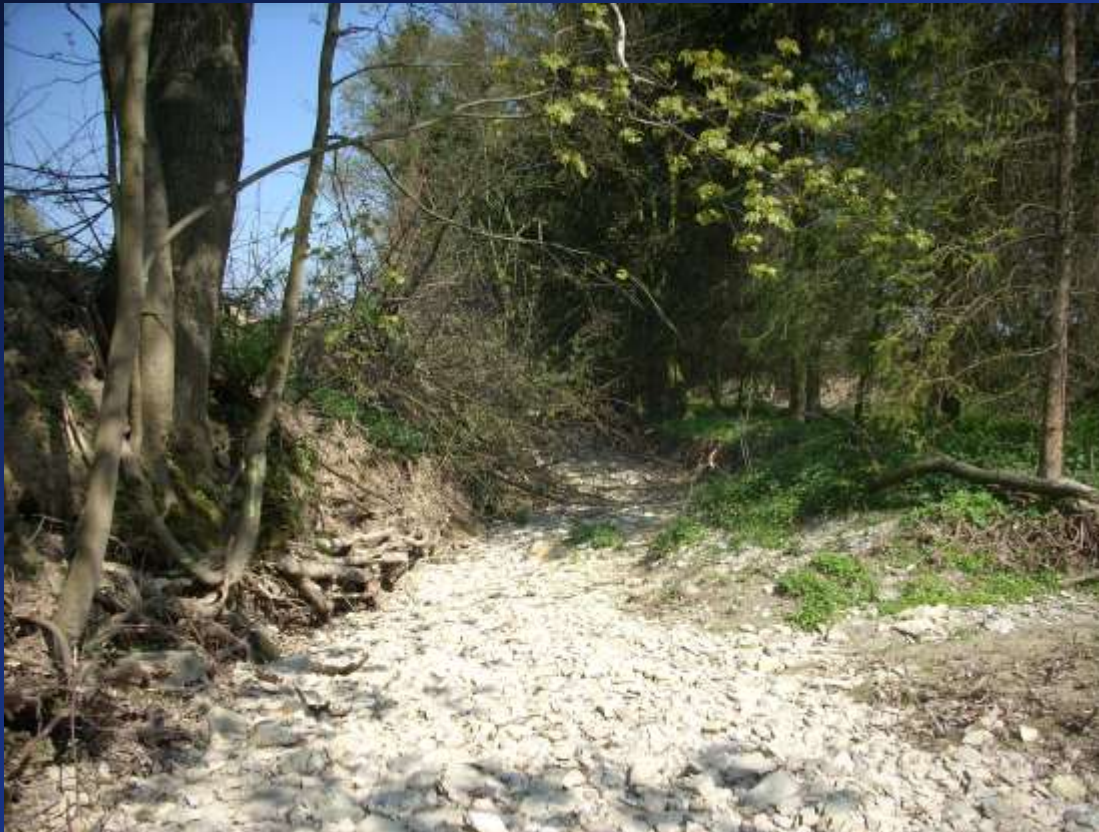
Trotzbach, Stat. km 15+500
