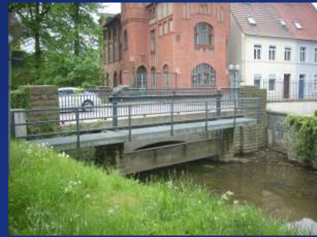
Südliche Umflut, Stat. km 2+400
