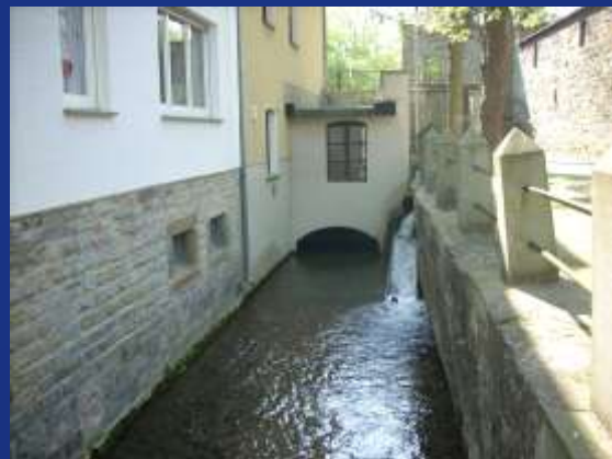
Mühlenbach, Stat. km 2+628
