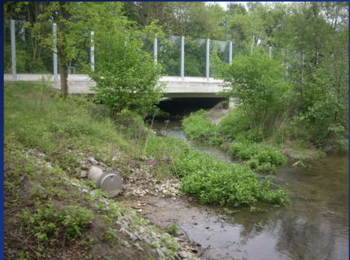
Südliche Umflut, Stat. km 1+590
