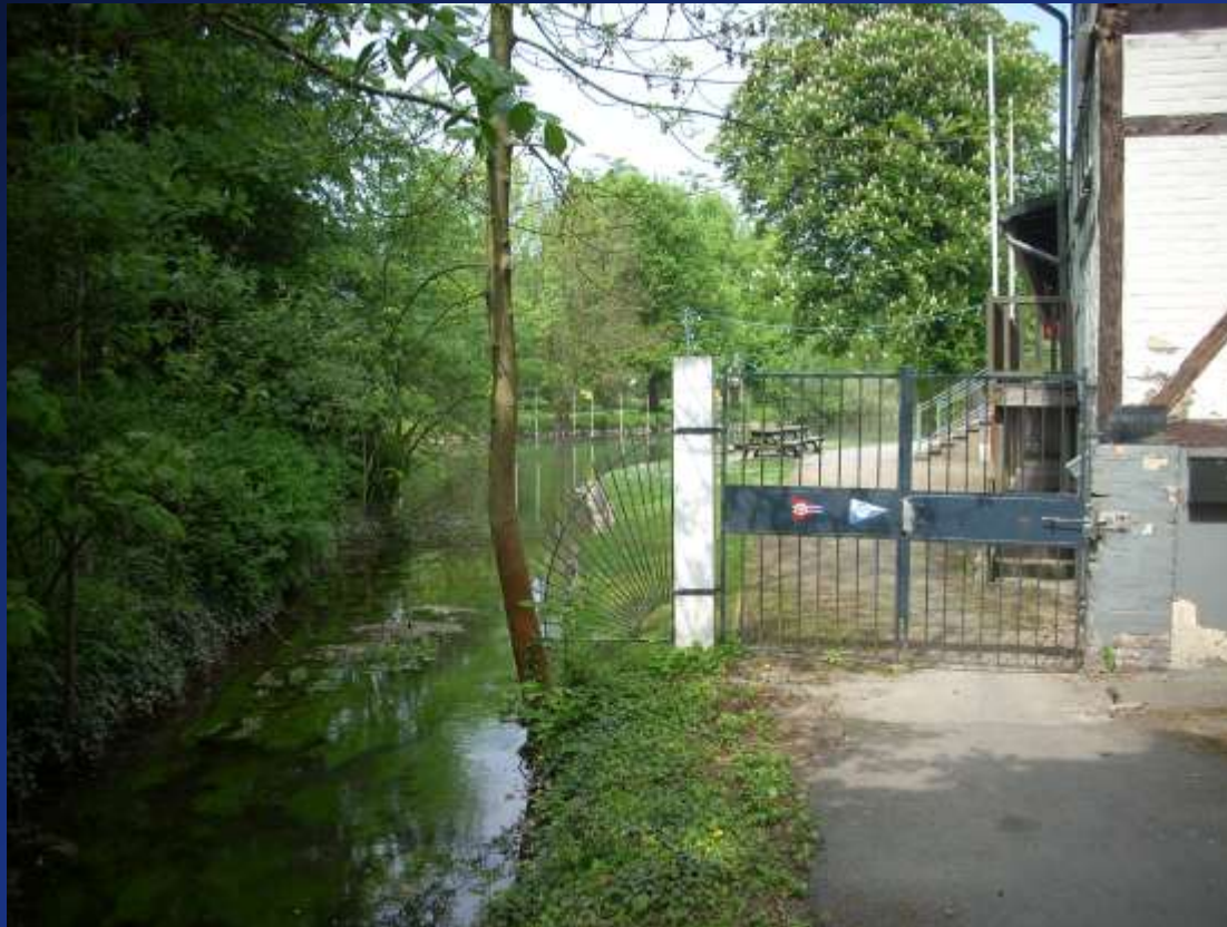
Südliche Umflut, Stat. km 2+450
