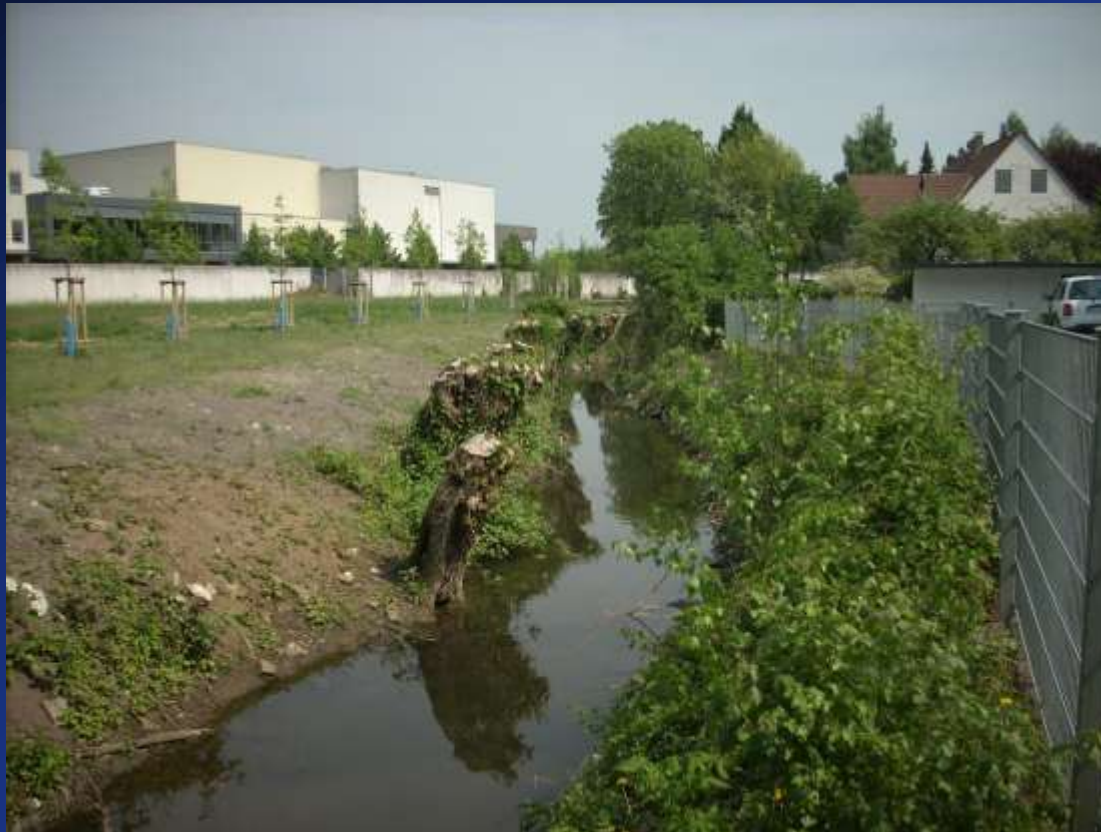
Südliche Umflut, Stat. km 0+900
