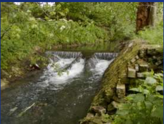
Trotzbach, Stat. km 4+712
