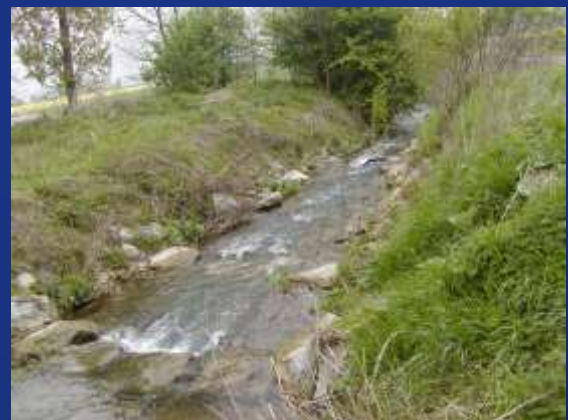
Trotzbach, Stat. km 6+236
