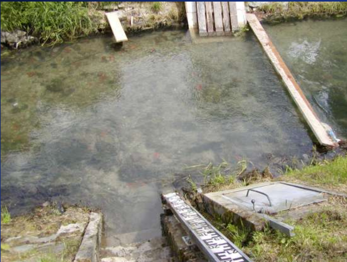
Gieseler, Pegel Boekenfoerde 2, Stat. km 11+000
