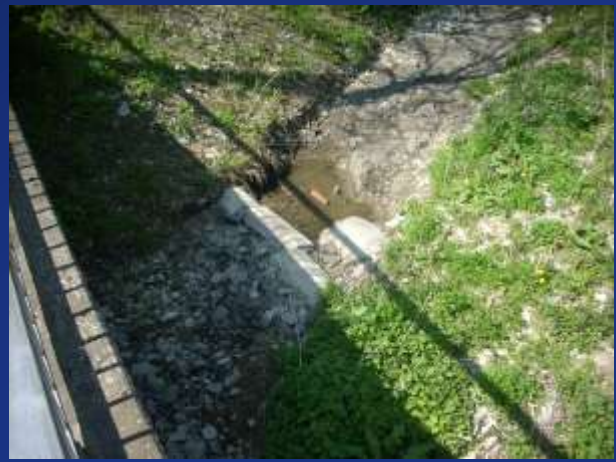
Trotzbach, Stat. km 9+220
