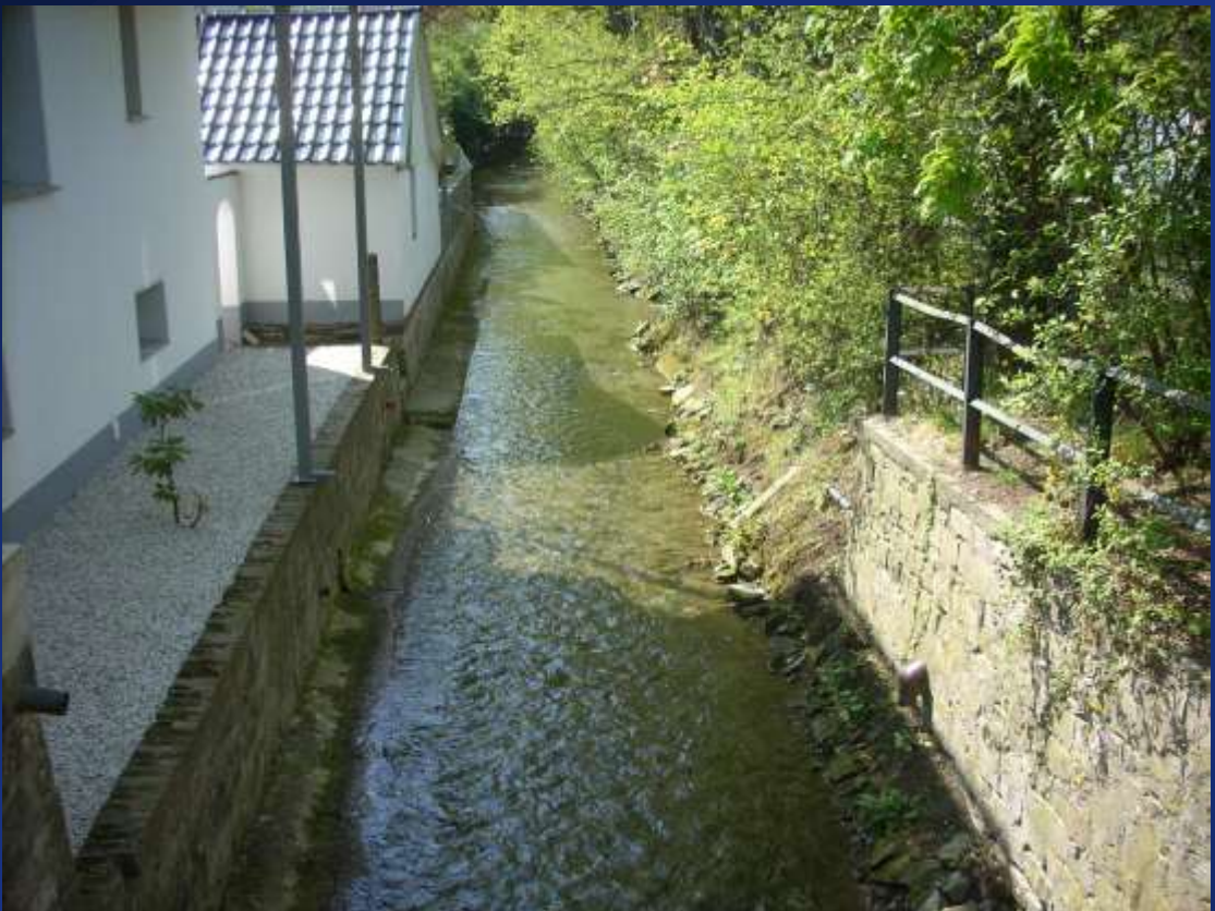
Mühlenbach, Stat. km 2+390
