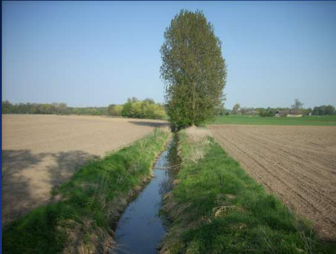
Steinbach, Stat. km 3+960
