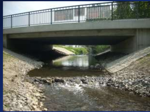
Südliche Umflut, Stat. km 0+810
