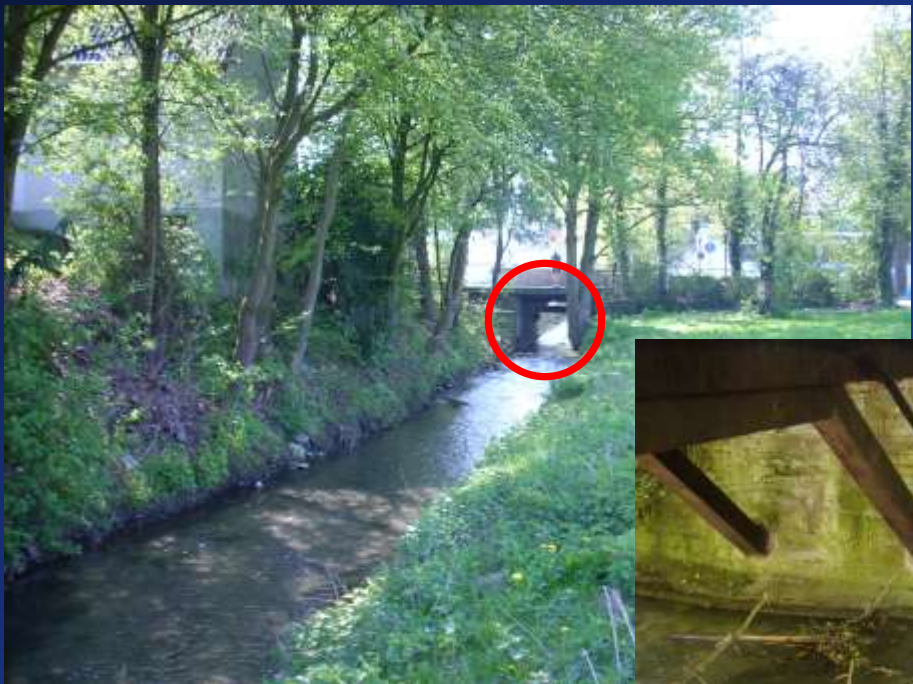
Mühlenbach, ehem. Pegel Erwitte, Stat. km 2+446
