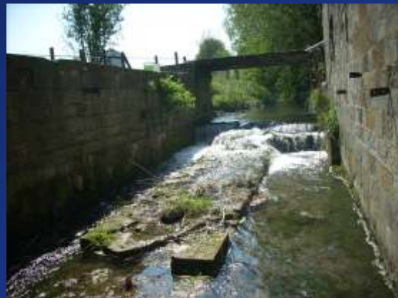
Mühlenbach, Stat. km 1+520
