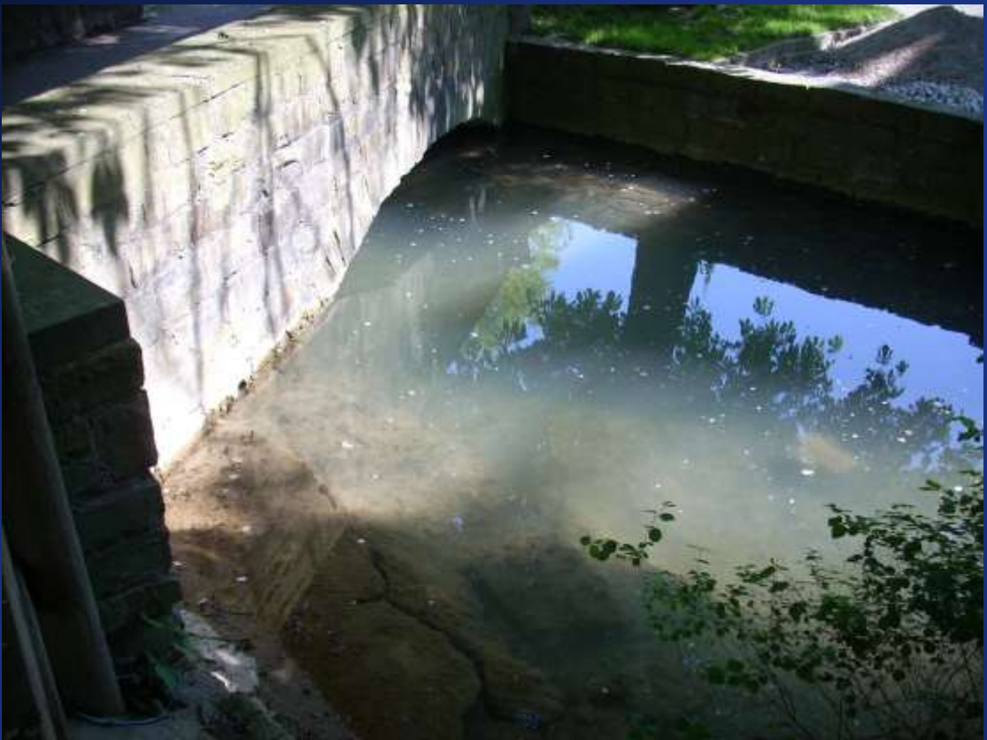
Mühlenbach, Stat. km 2+760
