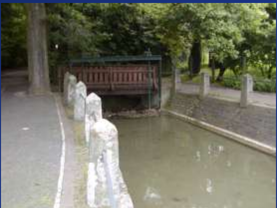
Mühlenbach, Stat. km 2+559
